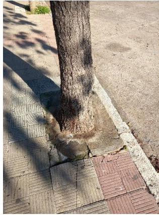
(Foto de la cubierta de cemento, realizada durante la inspección de diciembre de 2023)
