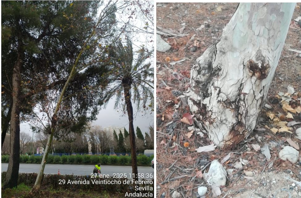
(Foto realizada antes de su apeo)
