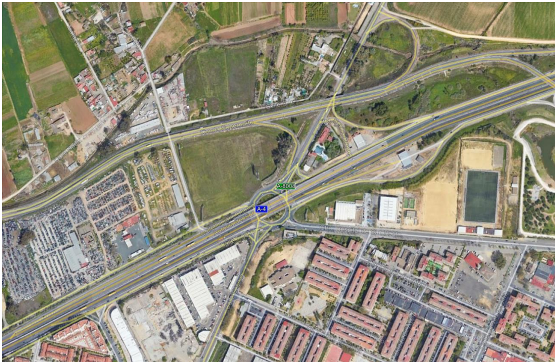
Figura 118. Detalle enlace SE-20 y A-4, siendo necesario utilizar la carretera A-8008
