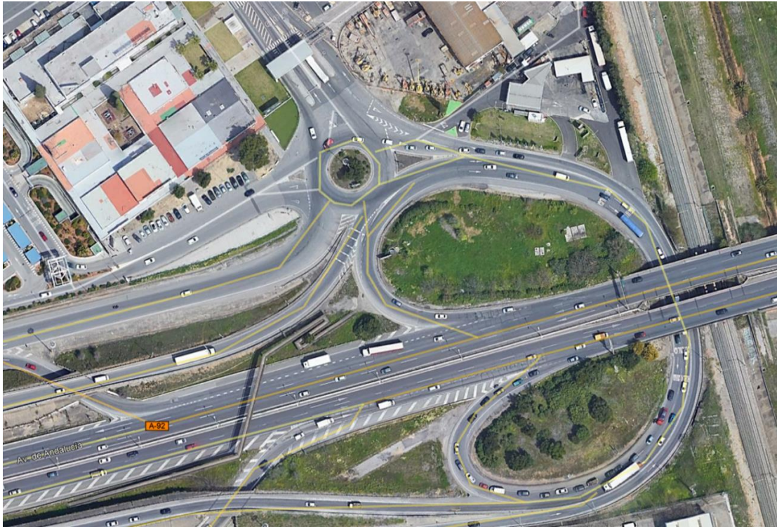
Figura 117. Detalle enlace A-92 y SE-30 a la altura de Mercasevilla
