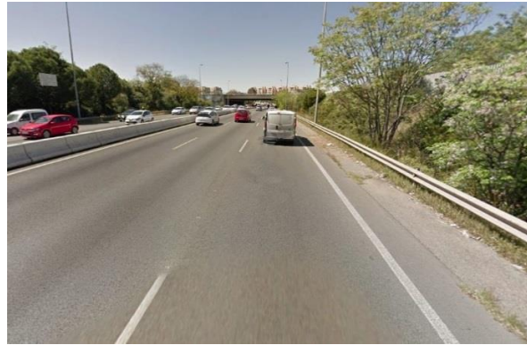
Figura 24. Situación actual de la zona Noreste de la Ronda Urban Norte, con arcenes y barreras a ambos lados.
